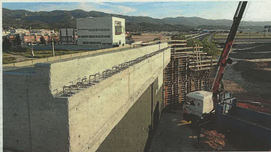
Estribos del nuevo viaducto, en el lado derecho de la autovía en dirección Cartagena. :: GUILLERMO CARRIÓN
