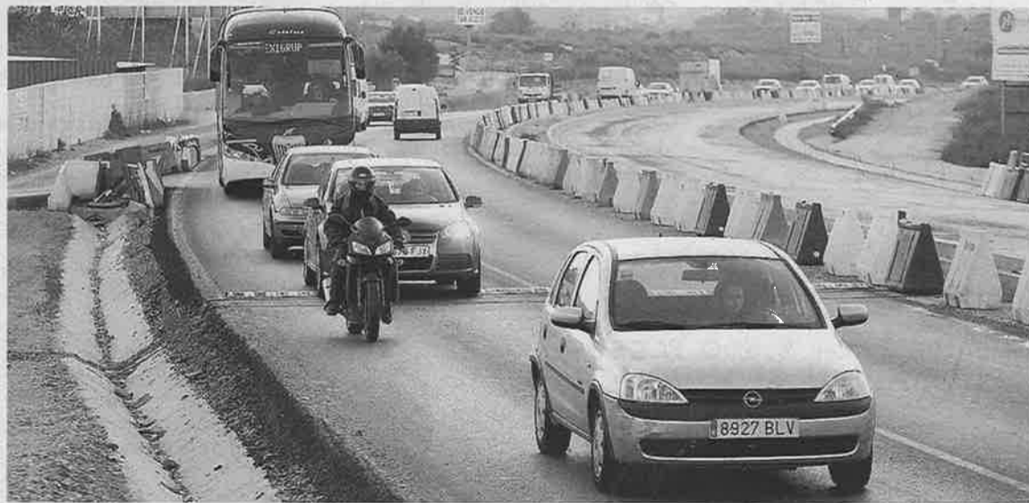
Tramo asfaltado entre la A-7 y Montepinar, donde se ha desdoblado la carretera antigua. :: F. MANZANERA
