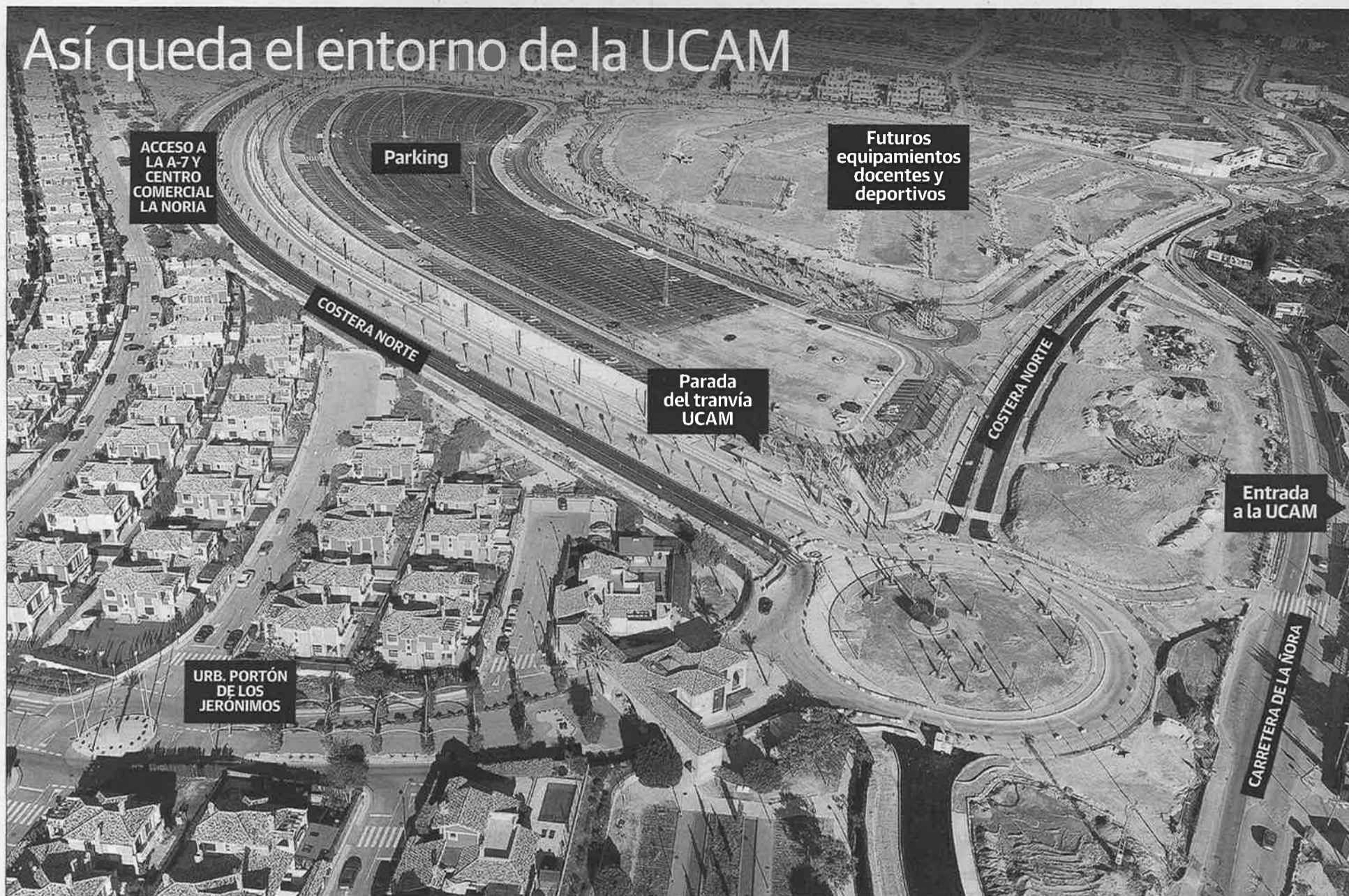
Imagen aérea tomada el 20 de diciembre en la que se aprecia el tramo de la Costera Norte en construcción entre Guadalupe y la rotonda de acceso al recinto de la UCAM. :: URBAMUSA
